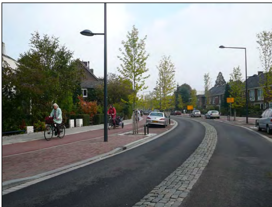
Figuur 4.5: Voorbeeld profiel met een ander type verharding als asmarkering (Delft)
